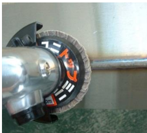
溶接ビード処理
